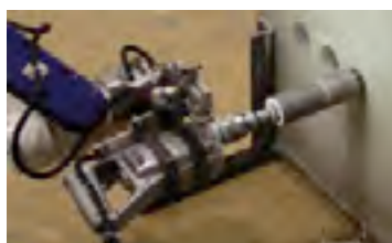
コアボーリング
