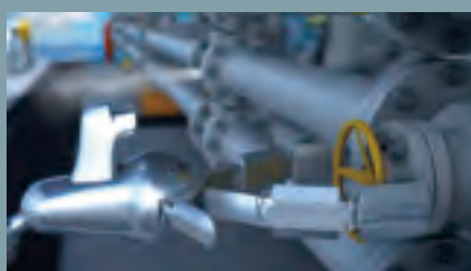
搭載ハンドによるバルブ開閉作業
