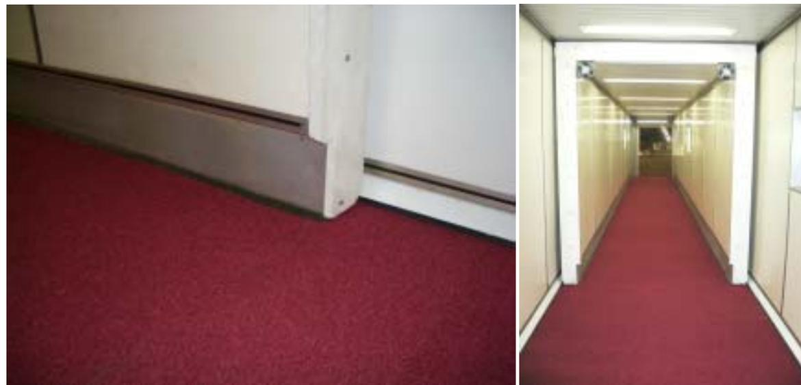
新型PBBのトンネル間(段差無し)
