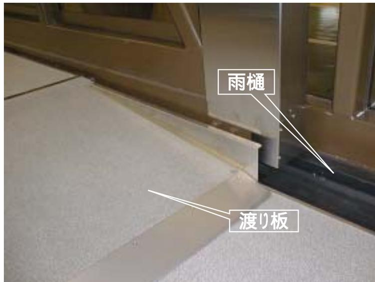
従来型PBBのトンネル間(段差有り)
