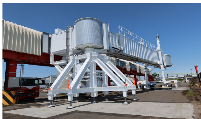
MMB全体（歩道橋側）
