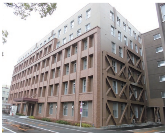
鉄骨外付ブレース
