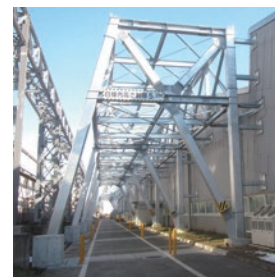
アウトフレーム 耐震工事後
