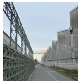
アウトフレーム 耐震工事前
