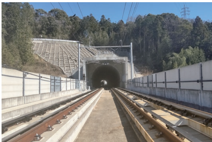
九州新幹線（西九州）木場トンネル他 長さ：L=2,885m 竣工：2022年
