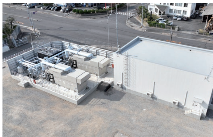
広島ガス株式会社 発電設備建設工事 ガスコージェネレーションシステム ガスエンジン1,000kW×2台 構造:RC造 階数:地上1階建 延べ面積:200㎡ 竣工:2023年
