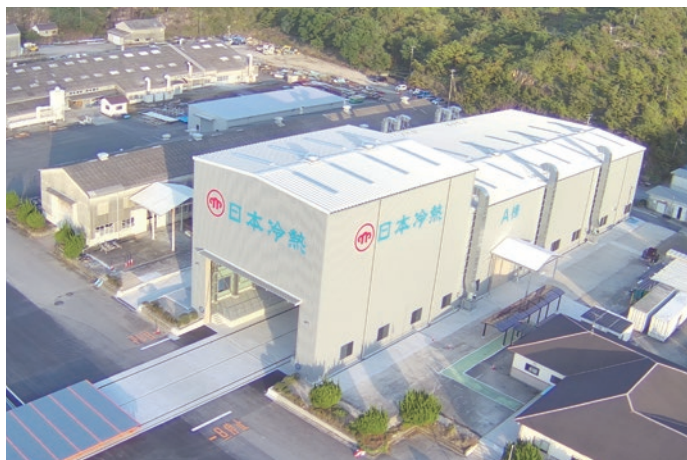
日本冷熱天草工場 A棟新築工事
