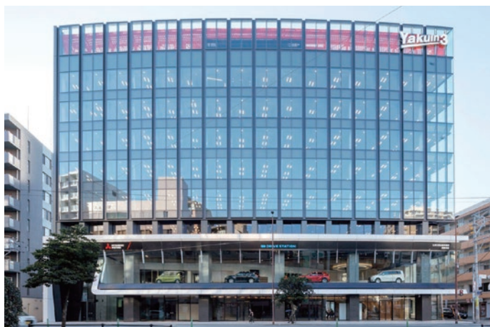
九州三菱自動車販売株式会社 KMGBビル (Yakuin3) 構造：S造 階数：地上8階建 延べ面積：10,400㎡ 竣工：2021年
