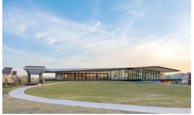
アイコクアルファ株式会社 発祥の地再開発事業 『いこいの広場』 構造：S造 階数：地上2階建 延べ面積：796㎡ 竣工：2021年
