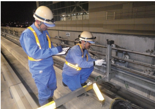
新交通軌道設備保守点検
