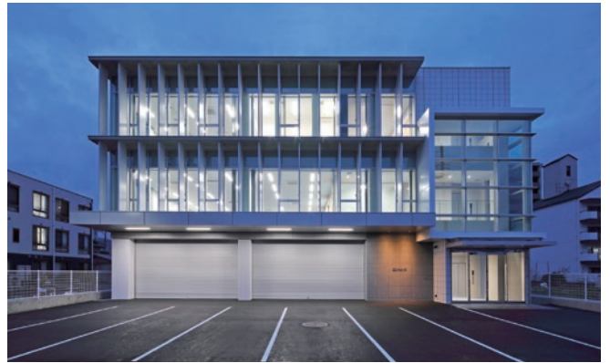
ネットエックス 本社ビル 構造：S造 階数：地上3階建 延べ面積：860㎡ 竣工：2020年
