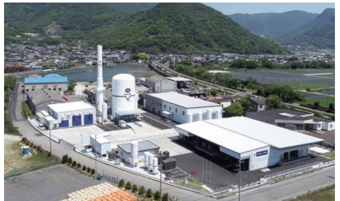
エア・ウォーター西日本株式会社 香川工場、讃岐液酸VSU工場 構造：S造 階数：地上1階建 延べ面積：3,371㎡ 竣工：2020年
