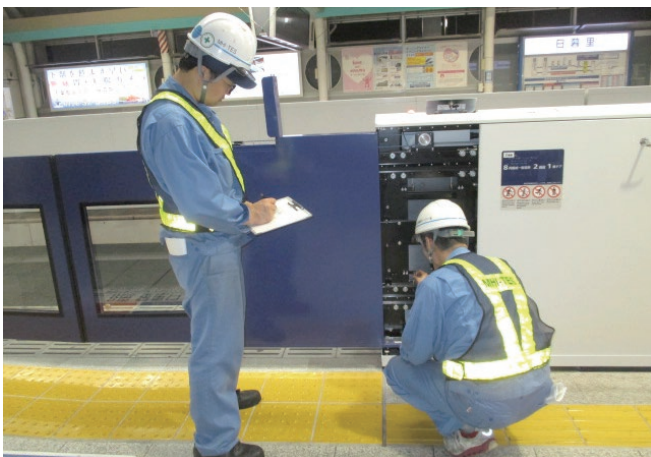
ホームドア保守点検
