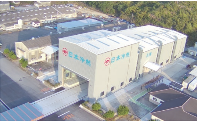
日本冷熱天草工場 A棟新築工事 構造：S造 階数：地上1階建 延べ面積：2,125㎡ 竣工：2022年
