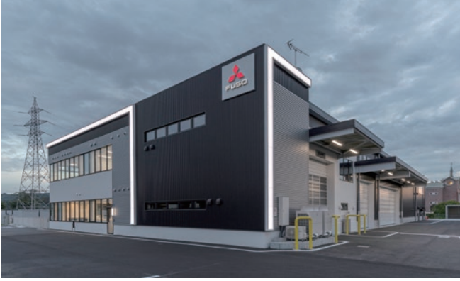
三菱ふそうトラック・バス株式会社 東北ふそう仙台支店 大河原サービスセンター 構造：S造 階数：地上2階建 延べ面積：1,807㎡ 竣工：2022年
