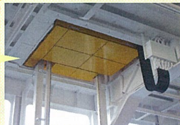
車両区画天井格納
