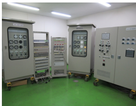
各種制御盤の製作・デバック
