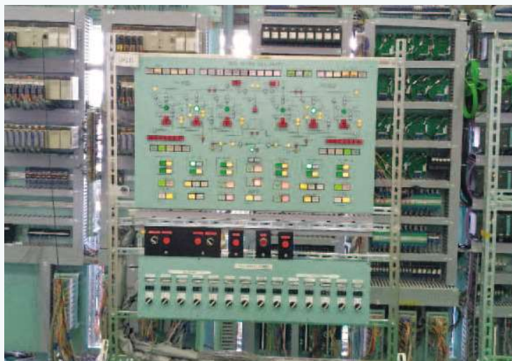
低硫黄燃料油の使用に伴うパネル換装
