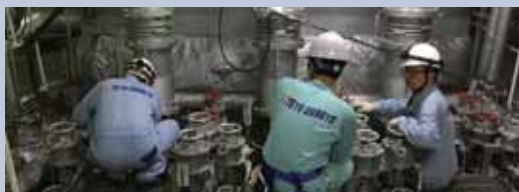
制御装置の機器改造工事
