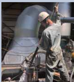
燃焼装置のスプレー取付改造工事
