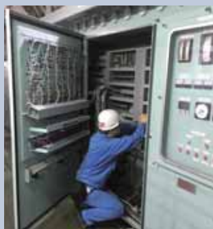
制御装置のバルブ改造工事
