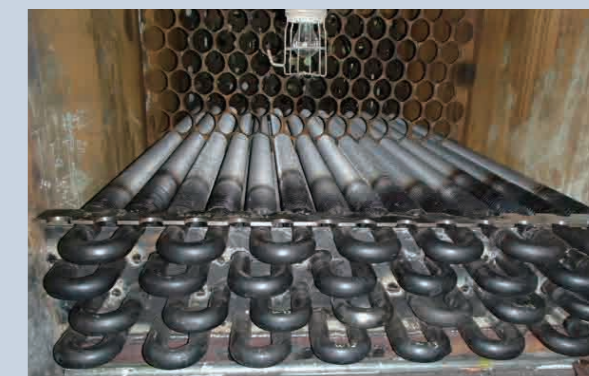
節炭器管の換装工事
