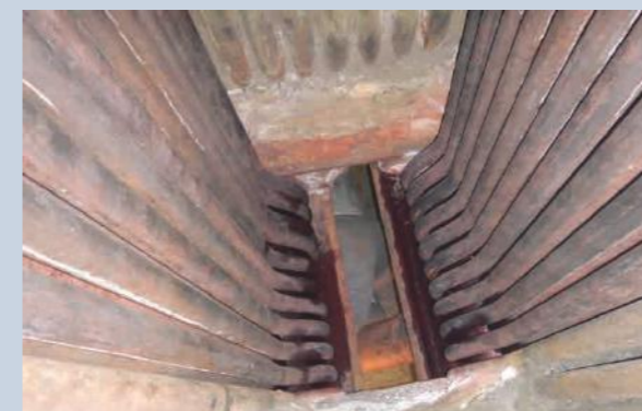
過熱器管換装工事
