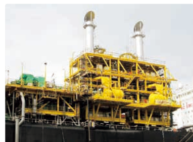
デッキボイラ
