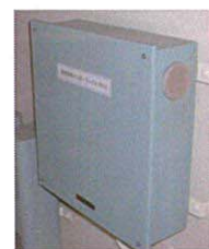
インターフェースボックス 外部信号とのやり取りを行います。(居住区設置)
