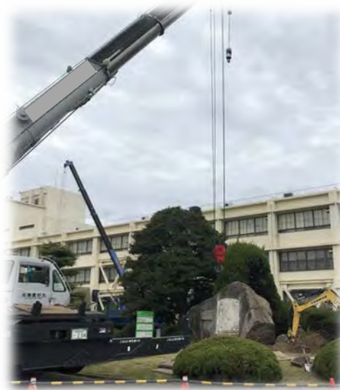
2019年11月 岩塚工場 掘出・移転
