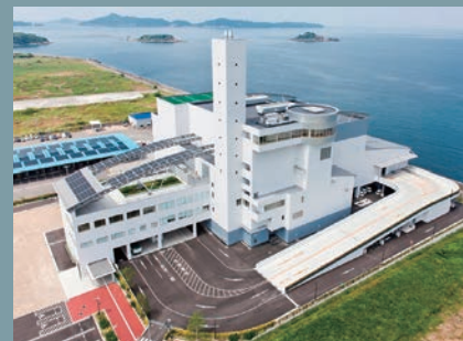
都市ごみ焼却発電施設
