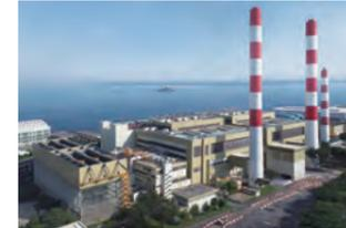
現在シンガポールで既存の4プラントのうち、3プラント(SIP、TIP、TSIP)を当社が納入しています。中でも廃棄物処理の需要の高まりから2000年に建設されたTSIPプラントは同国最大、また世界においても最大級の処理量(4,320t/日)を誇り、都市衛生に大きく貢献しています。
