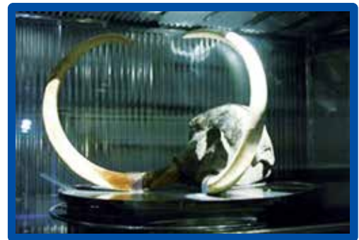
2005年愛知万博マンモス展示室 CO 2 /NH 3 冷却設備
