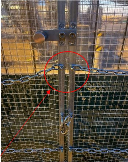
安全対策：カーテン柱の締め付け部に袋ナット採用
