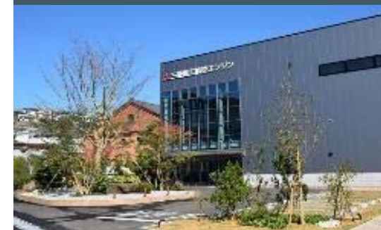
航空エンジン新工場稼働
