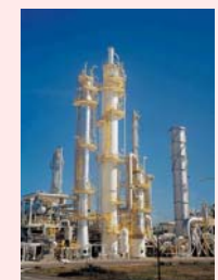
CO 2 回収プラント
