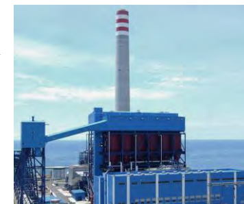
サービス提供中のプラント
