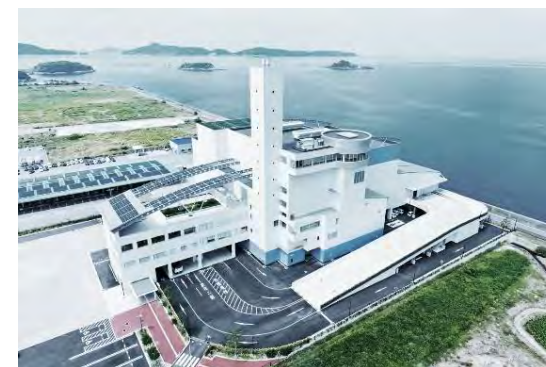
ごみ焼却プラント
