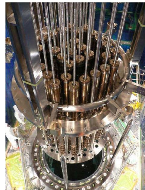
炉内構造物取替
