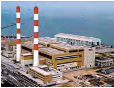
シンガポール政府環境省 /TUAS-SOUTH 4,320t/日(720t/日×6基) 2000年3月竣工
