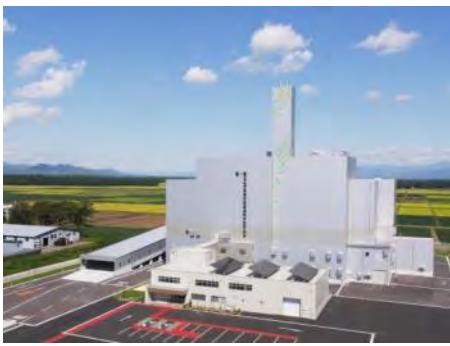
岩手中部広域行政組合/岩手中部クリーンセンター 182t/日(91t/日×2基) 2015年9月竣工
