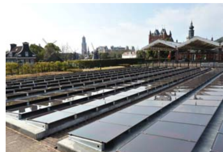
当社製微結晶タンデム太陽電池適用例 (ハウステンボス)
