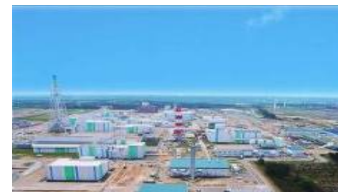
六ヶ所再処理工場
