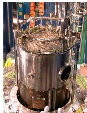
炉内構造物取替工事
