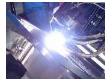
遠隔自動溶接
