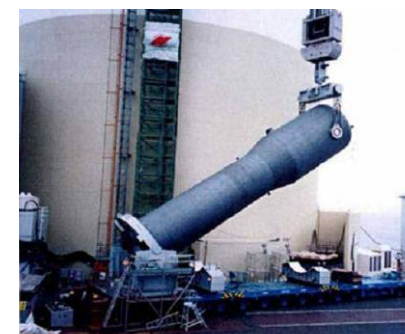
蒸気発生器取替工事
