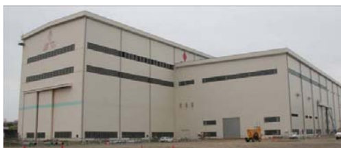
神戸(二見) 原子炉容器/炉内構造物工場
