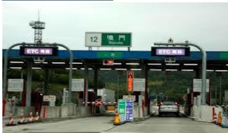
高速道路向けETC設備 受注
