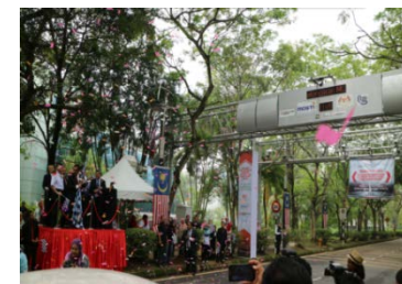
ETCシステム実証実験 (マレーシア)
