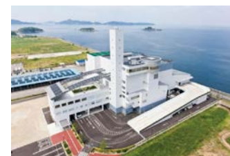
廃棄物処理設備
