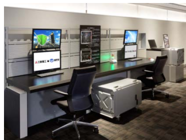
サイバーラボ (技術開発・実証拠点)
