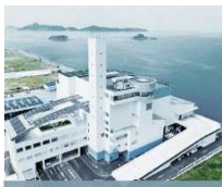
都市ごみ焼却発電プラント
