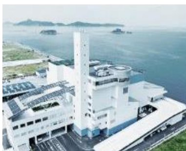
都市ごみ焼却発電プラント
