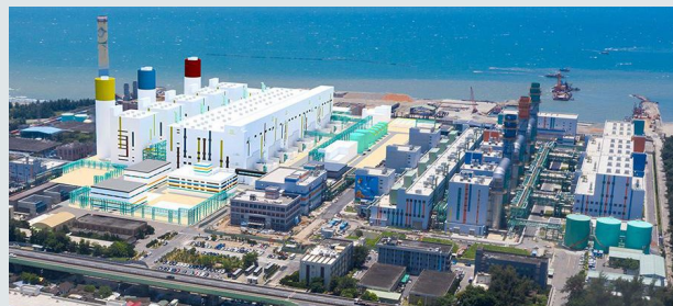
通霄発電所完成イメージ
