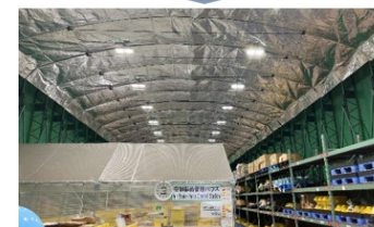
工場建屋への断熱材施工による遮熱対策
