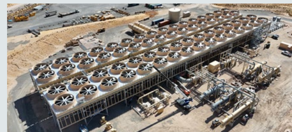
次世代地熱プロジェクト 現地に建設中のORC設備
