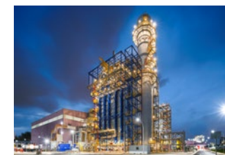
Keppel Sakra-1 GTCC発電所 (シンガポール) 写真提供:ケッペル社
