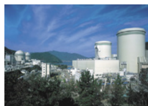
関西電力(株)高浜発電所
