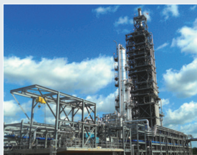
CO 2 回収プラント
