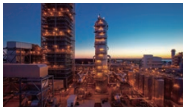
CO 2 回収装置
