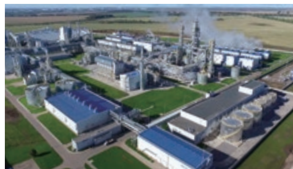
アンモニアプラント
