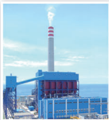
▲ バイトンⅢ火力発電所
