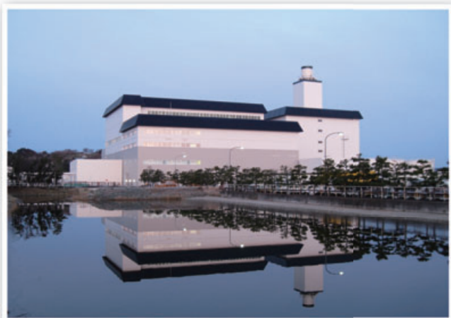
▲ 東北電力(株)仙台火力発電所4号機
