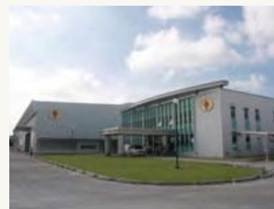
竣工した「エガットダイヤモンドサービス」のガスタービン高温部品補修工場
