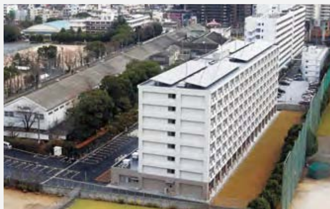
三菱重工独身寮に導入された太陽電池パネル
