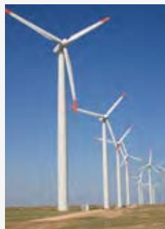
風力発電プラント
