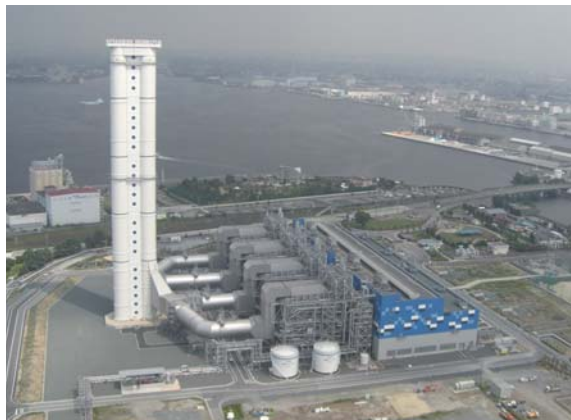
火力発電プラント(中部電力)
