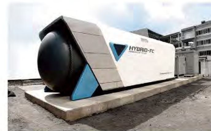
図8 九州大学での15式 SOFC-MGT ハイブリッドシステム実証機
