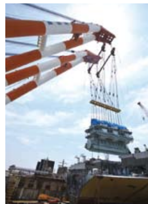
巨大なクレーンによるエンジンの設置
