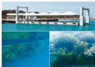
竹富島・竹富東港浮桟橋と浮桟橋に付着したサンゴ 電気防食によって生じる微弱電流で浮桟橋の側面にサンゴが付着(写真は2010年11月時点)
