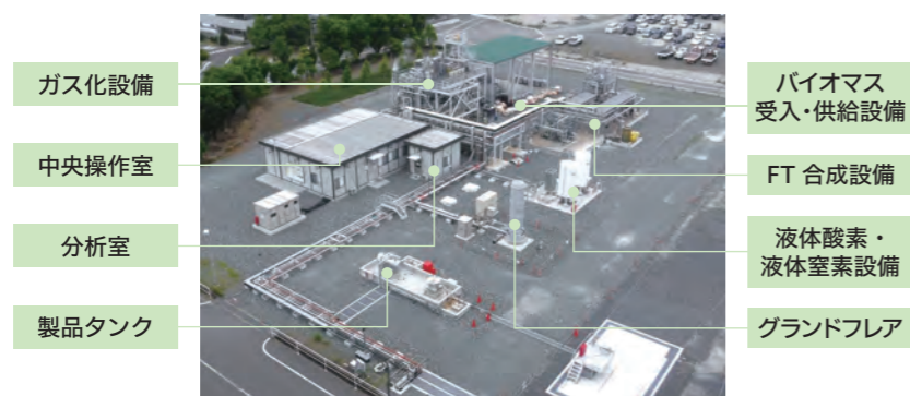
パイロットプラント全景
