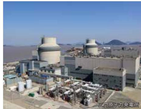
原子力発電所
