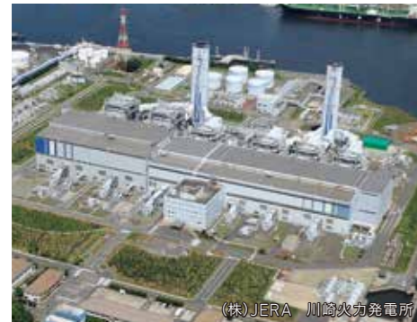
ガスタービンコンバインドサイクル(GTCC)発電所
