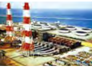
1985 世界最大級コンバインド発電プラント「東北電力、東新浜3号機第二系列545,000kW」完成
