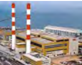
2000 シンガポール向け世界最大処理能力のこみ焼却炉引渡し
