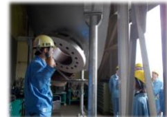
蒸気発生器内部作業 (コース4)
