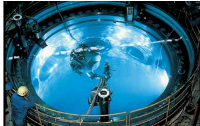
原子炉容器超音波検査装置（A-UTマシン）
