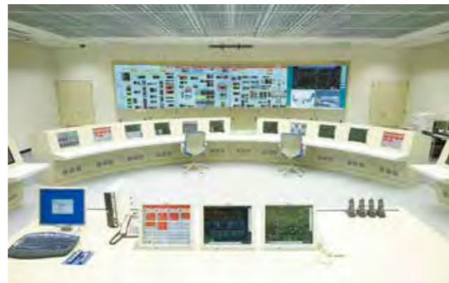
プラント運転シミュレーション
