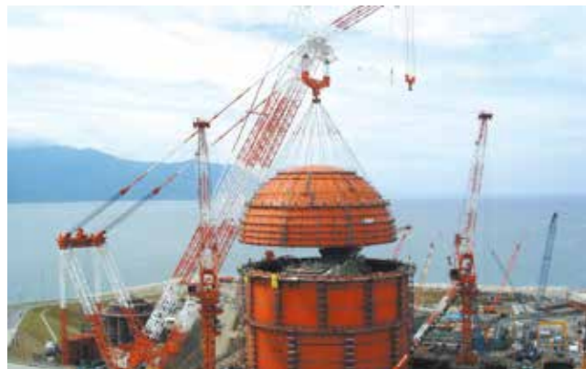
北海道電力株式会社泊発電所3号機建設風景
