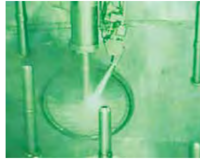
ウォータージェットピーニング応力改善工事
