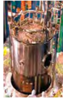
炉内構造物一体取替工事
