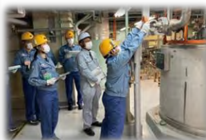
安全・安定運転への取組み
