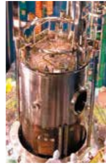
炉内構造物一体取替工事
