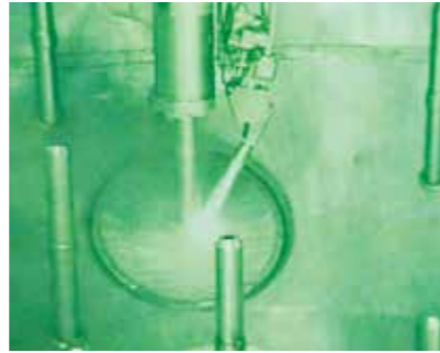
ウォータージェットピーニング応力改善工事
