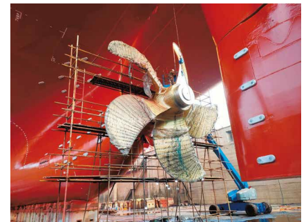
Propeller Retrofit
