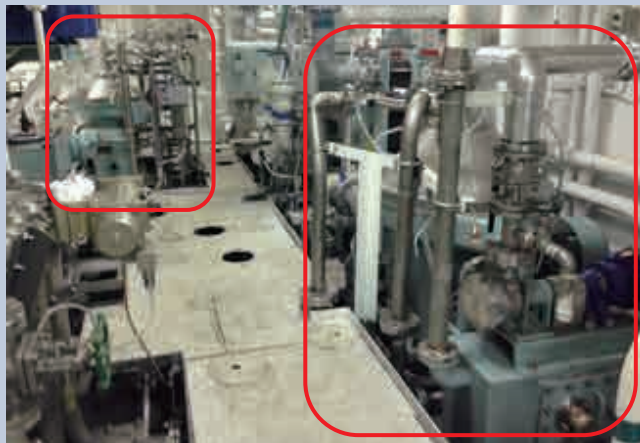
물 처리 장치 설치 상황
