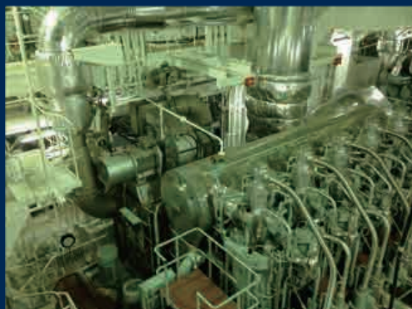
水处理装置的安装情况
