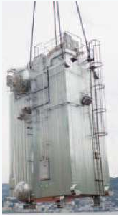
装船的再气化锅炉
