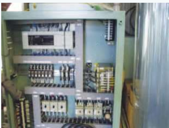
控制面板内的可编程控制器 (控制装置)
