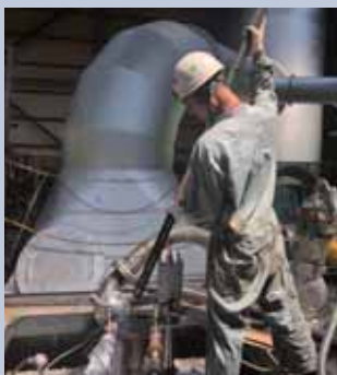
燃烧装置的喷嘴器安装改造工程
