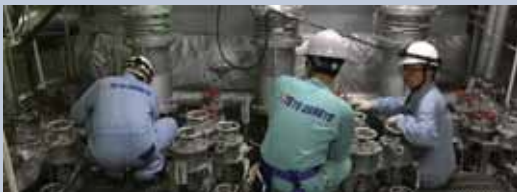
控制装置的设备改造工程
