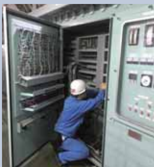
控制装置的面板改造工程
